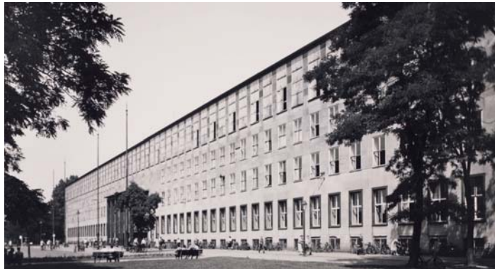
Das Hauptgebäude im Jahr 1952
