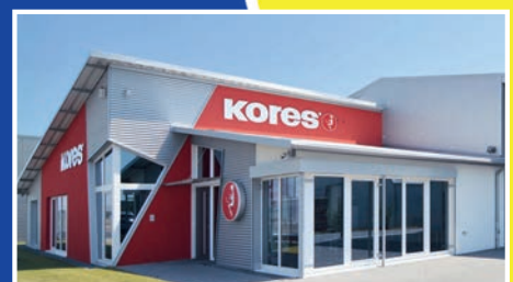
Neubau Verteilerzentrum, Neuss
