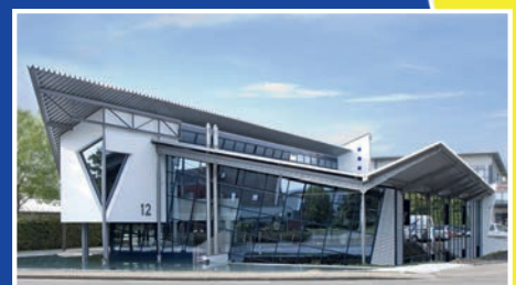
Neubau Verwaltungszentrum, Erkelenz
