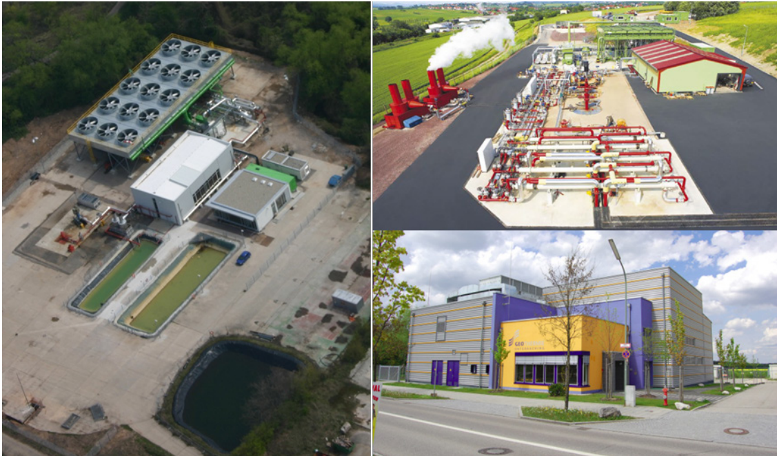
Abb. 5.4 Geothermie Anlagen drei verschiedener Standorte
