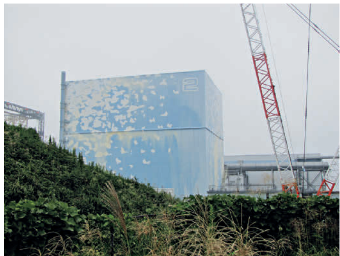
Abb. 3.19: Das praktisch unbeschädigte Reaktorgebäude 2 (Quelle: TEPCO).
