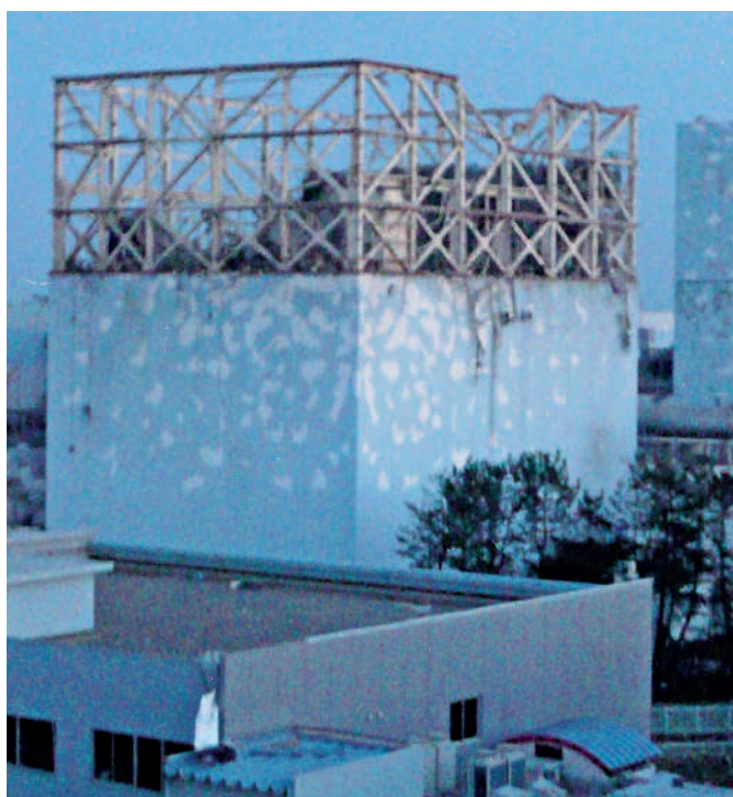
Abb. 3.14: Reaktorgebäude des Blocks 1 nach der Explosion am 12. März 2011 (Quelle: TEPCO).
