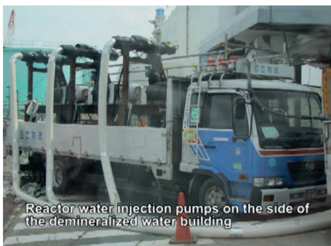
Abb. 6.1: Reaktoreinspeisepumpen und Ersatzaggregate (Quelle: TEPCO).
