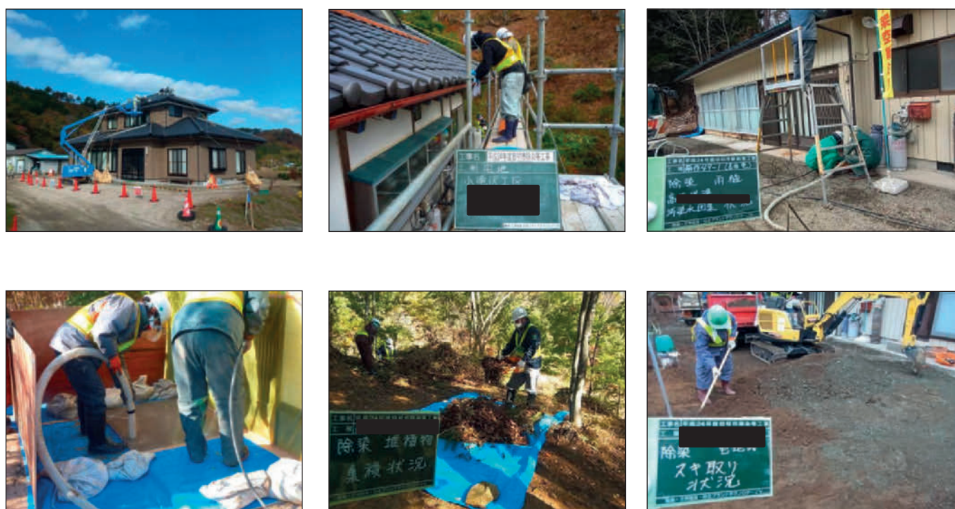
Abb. 5.21: Beispiele für Dekontaminierungsmaßnahmen, wie dem großflächigen Abtrag von kontaminierten Böden (obere Bildreihen und unterste Reihe mitte und rechts) und der Reinigung von Dächern und sonstigen Oberflächen, aufgenommen in der Stadt Tamura (Quelle: MoE).
