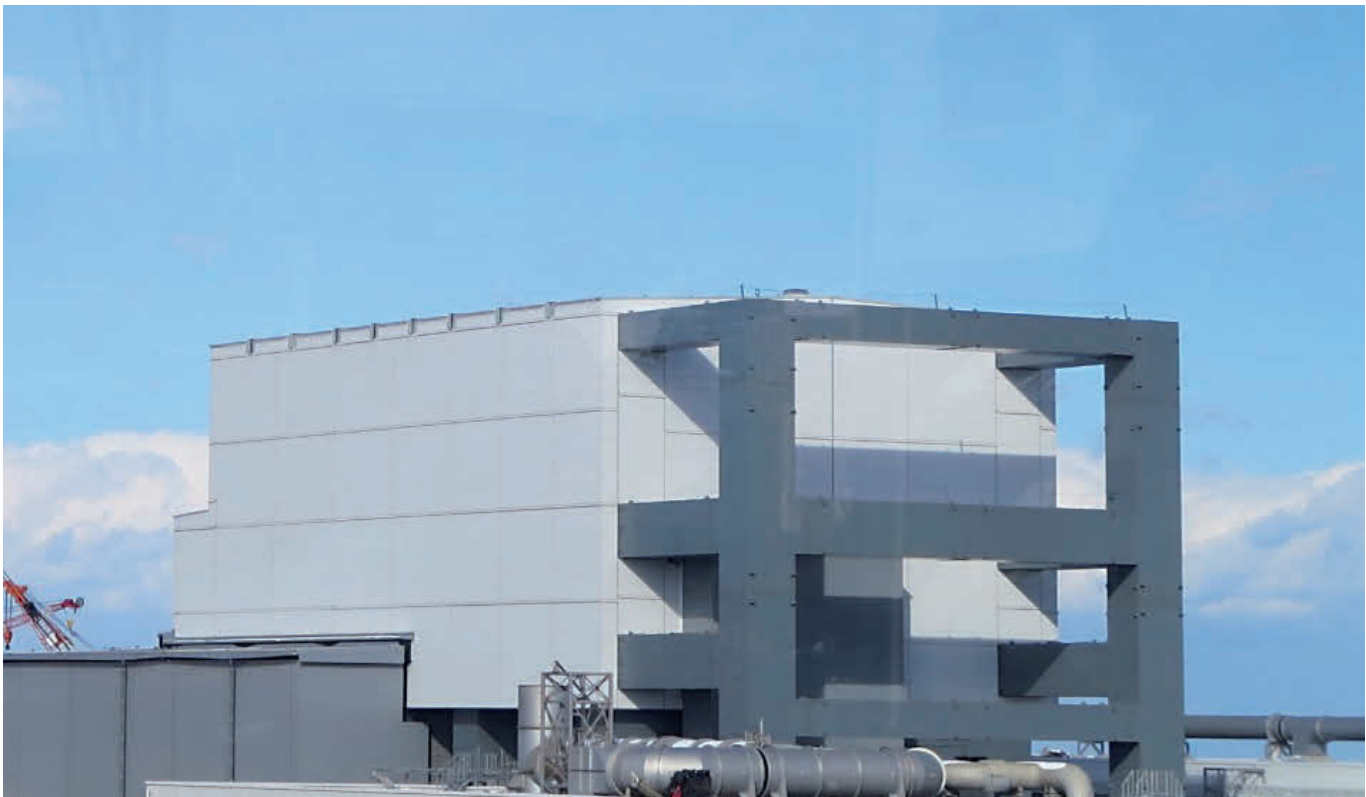
Abb. 6.23: Block 4 nach der Einhausung (Quelle: TEPCO).
