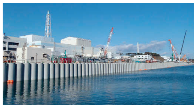
Abb. 6.15: Foto der aus Spundwänden errichteten Barriere (»shielding wall«), die in einigen Metern Abstand von der Kaimauer im Hafenbecken errichtet wurde (Quelle: TEPCO).
