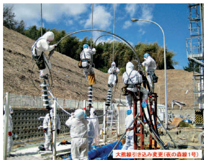
Abb. 6.5: Arbeiten zur Wiederherstellung der Anbindung der Anlage an das Stromnetz (Quelle: TEPCO).
