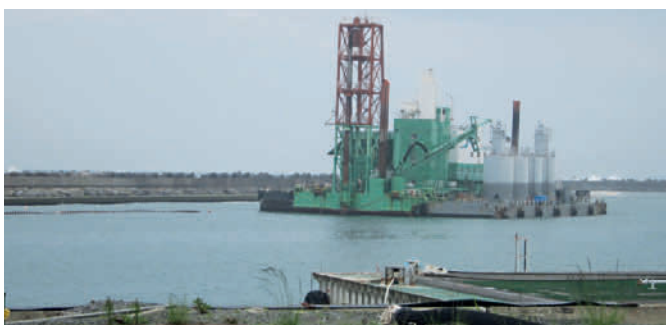
Abb. 6.18: Schwimmendes Arbeitsgerät zur Versiegelung des Meeresbodens (Quelle: TEPCO).
