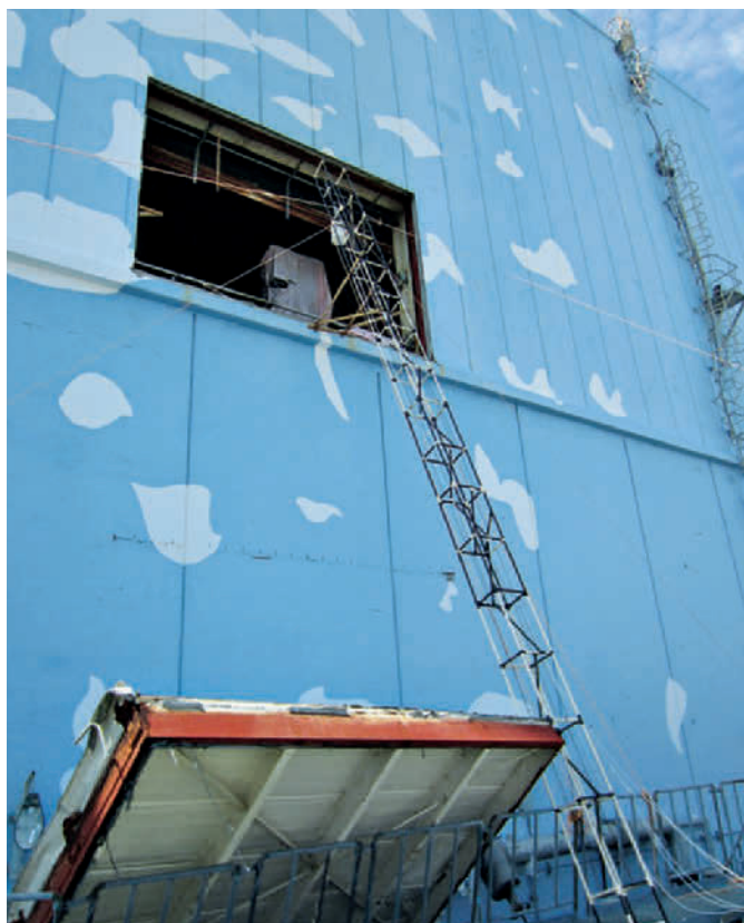
Abb. 3.20: Öffnung im Reaktorgebäude 2 (sog. »blowout panel«), die möglicherweise eine Ansammlung von Wasserstoff und damit eine Explosion verhindert hat (Quelle: TEPCO).
