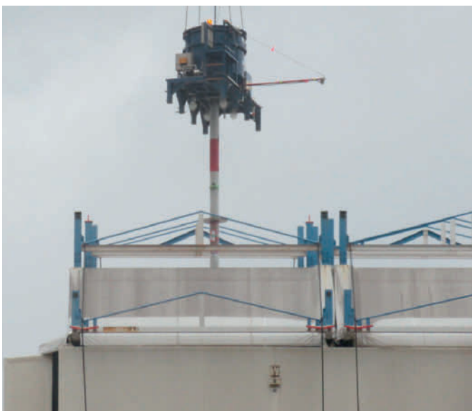
Abb. 6.20: Bohrungen in den Deckenelementen (Quelle: TEPCO).
