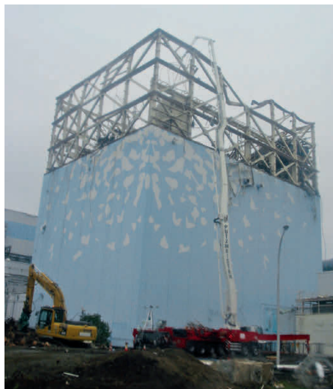
Abb. 3.15: Einspeisung von Wasser in das Brennelementlagerbecken des Blocks 1 mit einer Autobetonpumpe (Quelle: TEPCO).
