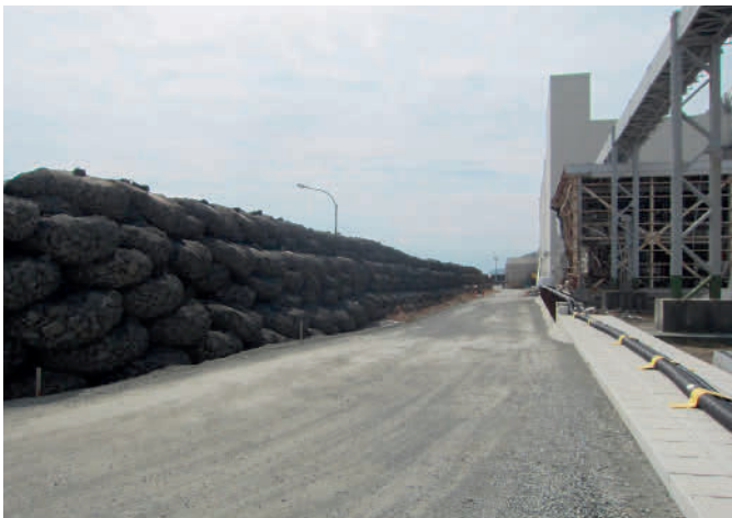
Abb. 6.2: Schutzwall gegen Tsunamis (Quelle: TEPCO).
