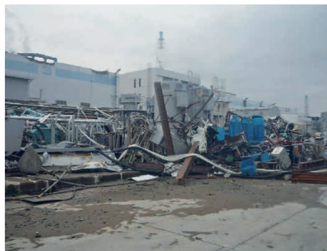
Abb. 3.13: Blick auf das Turbinenhaus von Block 3 (links im Hintergrund) nach dem Tsunami (Quelle: TEPCO).
