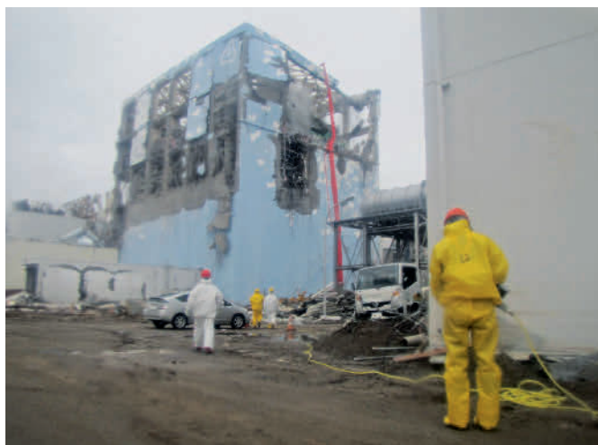
Abb. 3.30: Wassereinspeisung in Block 4 mithilfe einer Autobetonpumpe (Quelle: TEPCO).
