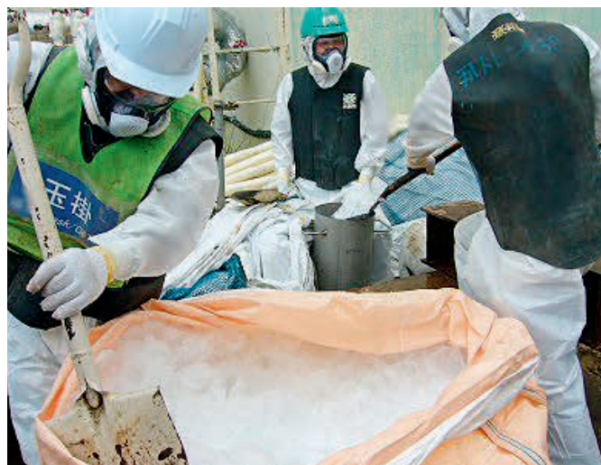
Abb. 6.17: Einbringen von Eis in einen Schacht des Rohrleitungstunnels im Maschinenraum von Block 2 (Quelle: TEPCO).
