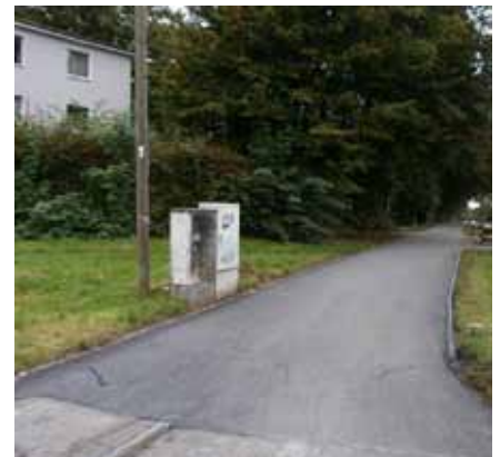
Die Oberfläche des Radwegs an der Butzweiler Straße wurde saniert.
