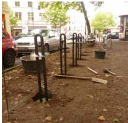
Bau einer neuen Abstellanlage für Fahrräder
