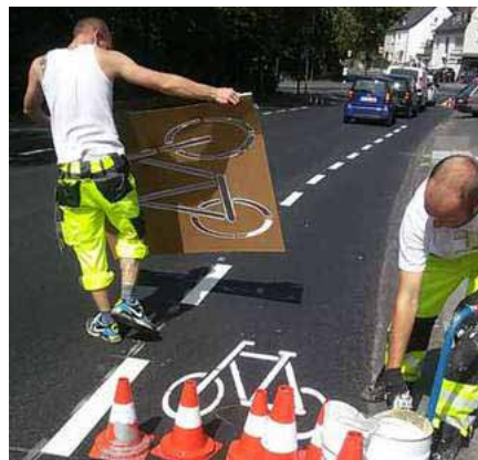
Markierungsarbeiten an der Honschaftstraße in Höhenhaus
