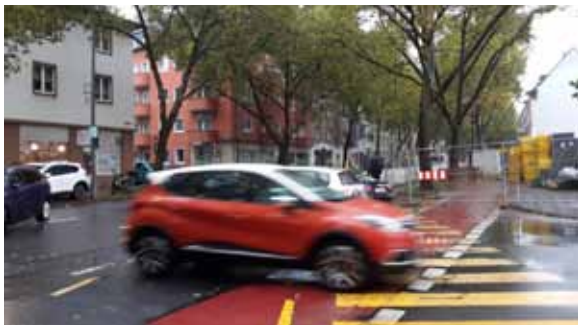
Baustelle am Maarweg
