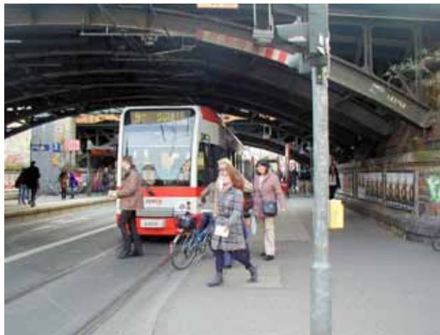
Die Beseitigung der Engstelle an der KVB-Haltestelle unter der Eisenbahnbrücke erfordert bei einer Sperrung für den Autoverkehr keinen Abriss und Neuaufbau der unter Denkmalschutz stehenden Brücke.
