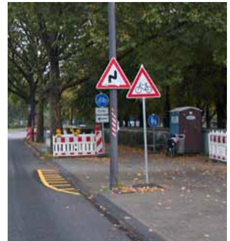
Baustelle an der Aachener Straße
