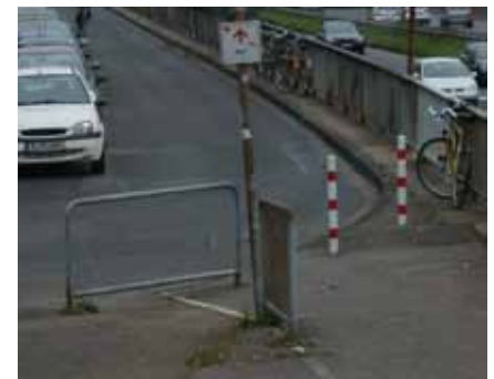
An der inneren Kanalstraße am Herkulshochhaus verengt ein Gitter unnötig die Auf- und Abfahrt.
