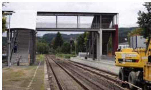
Bahnhof Overath: Der Zugang zum Bahnsteig erfolgt jetzt über eine neun Meter hohe Brücke.
