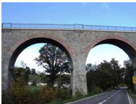
Viadukt bei Bruch [Foto: N. Schmidt]
