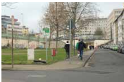
Eine Rampe zwischen Tunnel und südlichem Fuß- und Radweg würde die Anbindung an den Wiener Platz deutlich verbessern.
