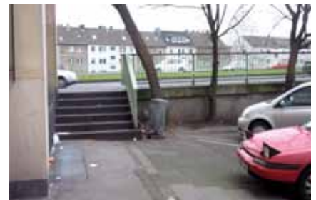
Eine Rampe anstelle der Treppe an der Nordseite der Brücke in Mülheim ist leicht eingerichtet und bietet – nicht nur – Radfahrern mehr Komfort.
