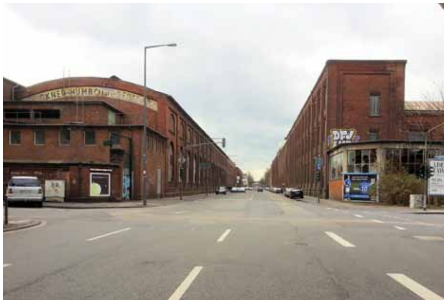
Die Deutz-Mülheimer Straße, die Zentralachse des zukünftigen Wohngebiets, bleibt nach den derzeitigen Planungen stadtbahnfrei. Das Foto zeigt die alten Werkshallen von Klöckner-Humboldt-Deutz an dieser Straße [Foto: Dr. Reinhard Zietz].
