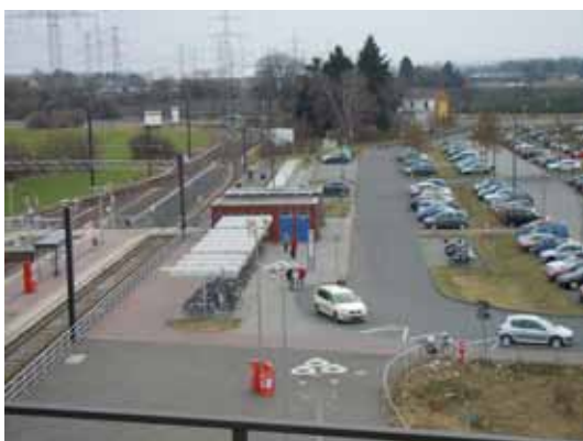
Park&Ride-Anlage am Nahverkehrsknoten Weiden-West
