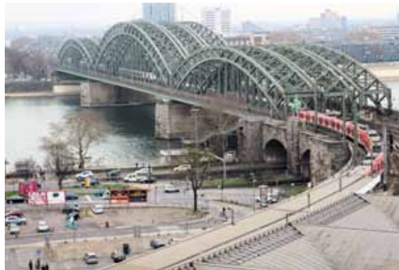
Allein in Köln sollen in den nächsten Jahren 30 Eisenbahnbrücken erneuert werden. Von 25.400 Eisenbahnbrücken in Deutschland sind 9.200 älter als 100 Jahre. 1.400 Brücken bundesweit sind dringend renovierungsbedürftig, davon 270 in NRW. [Foto: Bihn]
