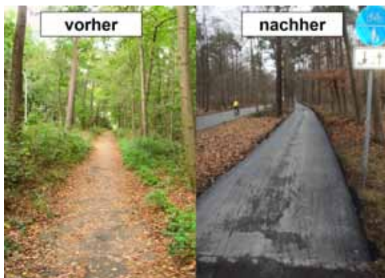
Sanierter Radweg an der Mielenforster Straße
