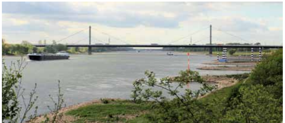
Die Leverkusener Brücke ist das Paradebeispiel für den Zustand vieler Brücken in Deutschland. Sie wurde zwischenzeitlich für den Schwerlastverkehr komplett gesperrt. Derzeit gilt eine Höchstgeschwindigkeit von 60 km/h. [Foto: Bihh]
