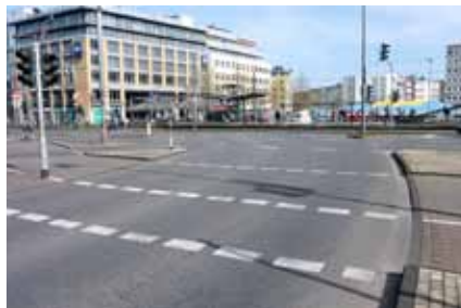
Linksabbieger von der Mülheimer Brücke zum Clevischen Ring: Hier könnte ein Schutzstreifen den Weg nach Norden erleichtern.
