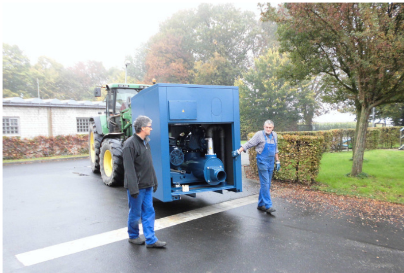
Bild: Transport des neuen Verdichters zur Gebläsestation
