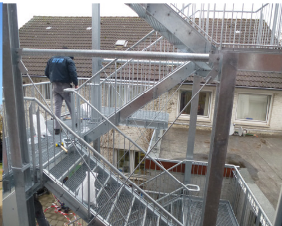
Umbau Familie-Harf-Haus - Fluchttreppen
