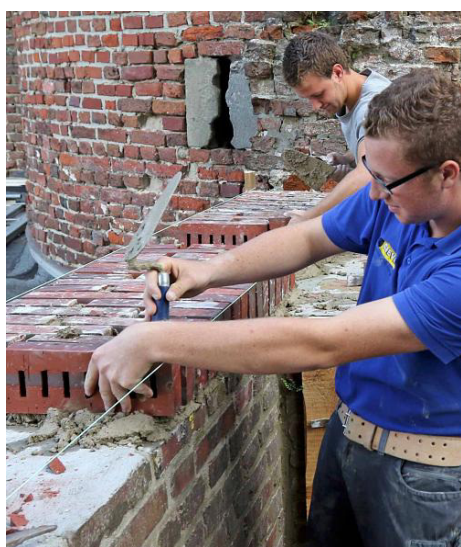
Sanierung Mauerwerk Burg
