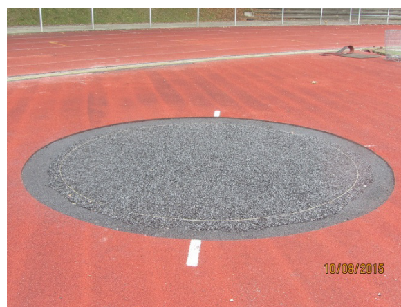
Rückbau der Kugelstoßanlage
