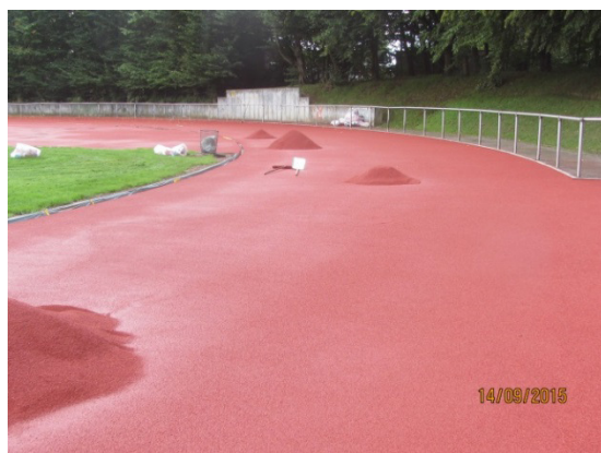
Erneuerung der Verlaufsbeschichtung
