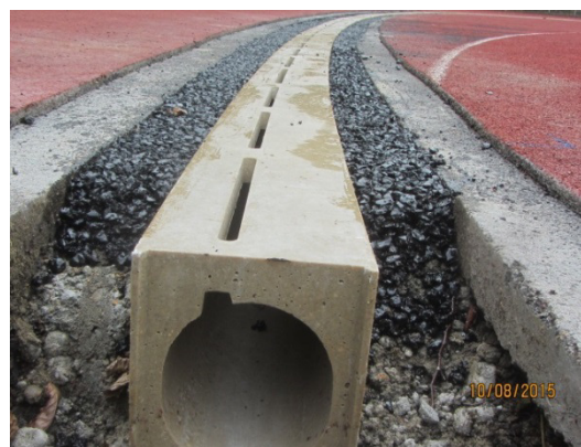
Einbau der Laufbahntwässerung
