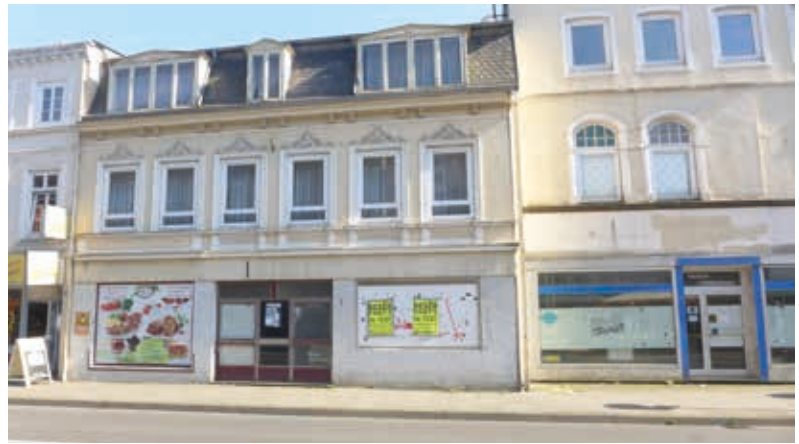
Leerstehende Geschäfte in Elmshorn.
