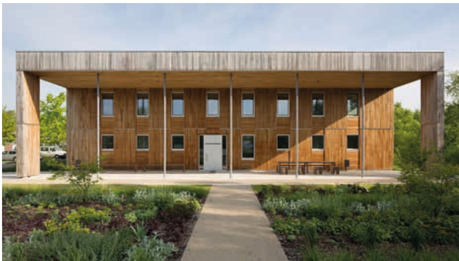
Vorbildlicher Bau: Bürogebäude des Umweltbundesamtes in Berlin-Marienfelde.
