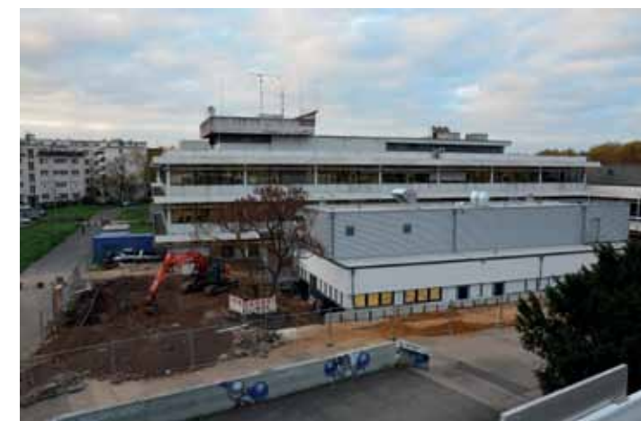
2. Physik: Die Baufortschritte sind unübersehbar.
