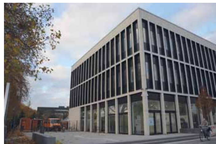
Das COPT-Gebäude, eines der drei Anwenderzentren für Organische Elektronik in Deutschland (mituns berichtete im Septemberheft), an der Luxemburgerstraße 90 wurde eingeweiht .
