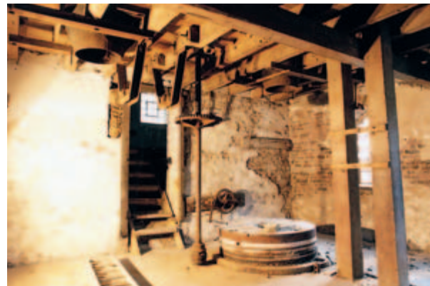
Niederpleiser Mühle vor der Restaurierung (2000)
