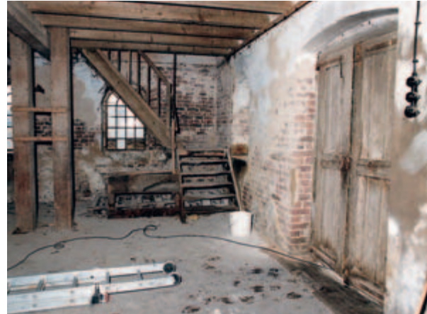
Niederpleiser Mühle vor der Restaurierung (2000)
