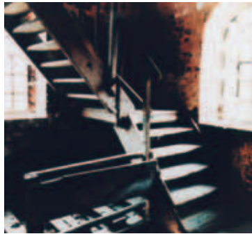
Treppe im Standesamt (vor der Renovierung)
