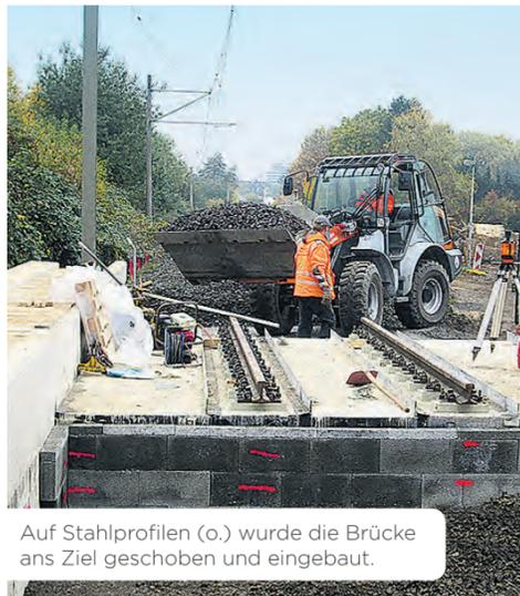
Auf Stahlprofilen (o.) wurde die Brücke ans Ziel geschoben und eingebaut.
