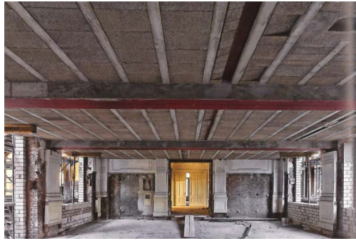
...mit der fertig eingebauten Zwischendecke (Foto: Thilo Kühne)
