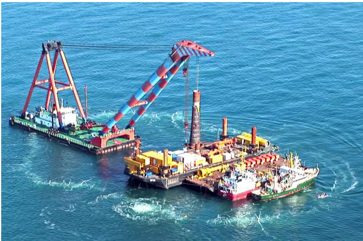
**Abb. 26:** Einsatz des Blasenschleiers zur Dämpfung des Unterwasserschalls während der Rammung eines Offshore-Fundamentes, Foto: F+E-Zentrum FH-Kiel GmbH
