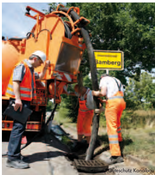
Fachpersonal der EBB gemeinsam mit vom Güteausschuss des Güteschutz Kanalbau beauftragtem Prüfenieur D. Walter bei der Qualitätsprüfung
