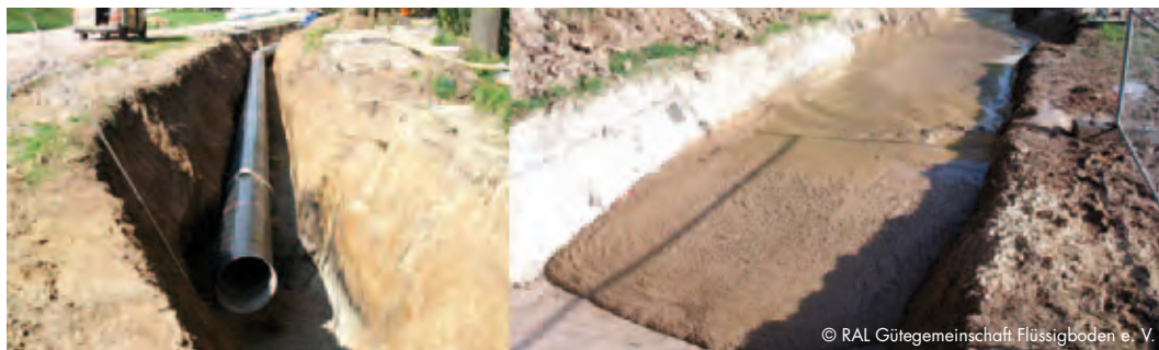
Vorher – nachher: Eine Trinkwasserleitung wird in Flüssigboden nahtlos eingebettet.
