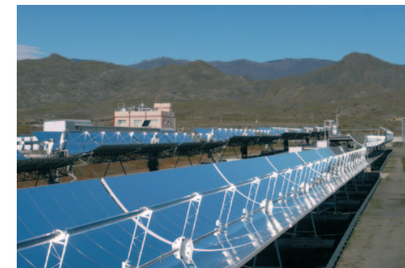
In der Testanlage DUKE (Durchlaufkonzept – Entwicklung und Erprobung) wird der Wasserdampf für die Stromerzeugung direkt in den Receiverrohren der Parabolrinnen erzeugt
