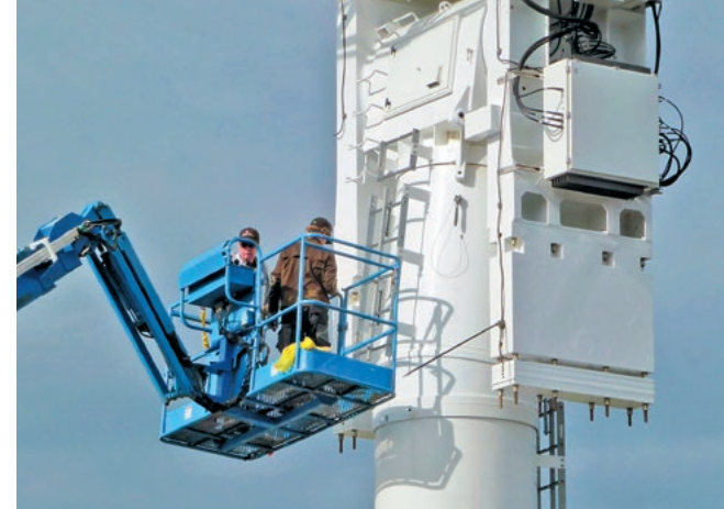
Mit der Arbeitsbühne zum Getrieberaum der Antennenanlage: Arbeiten in 15 Meter Höhe mit dem einen oder anderen kräftigen Windstoß
