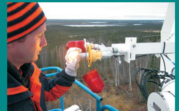
Auch das gehört zur Wartung: Lampenwechsel an der Antenne
