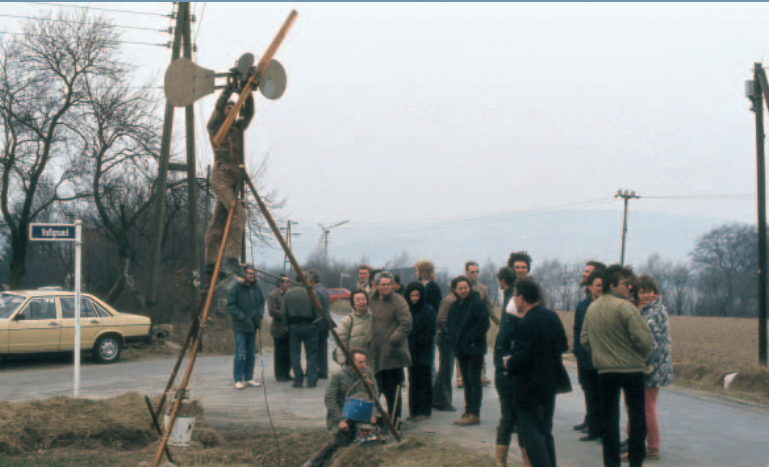
Weiterbildung in Sachen Windenergie anno 1984: Seminarteilnehmer in Vlotho testen eine umgebaute Lichtstrommaschine
