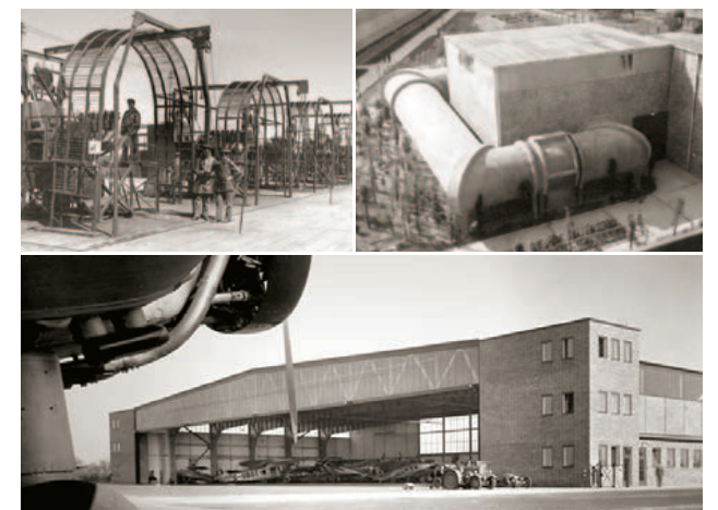
Techniker der Fliegertruppe vor offenen Motorenprüfständen mit Schutzgittern gegen Propellerbruch, um 1916/17, (Foto links oben); der Mittlere Windkanal mit Luftführung und Messhalle, um 1940, Foto rechts oben; Große Flughalle der DVL mit dem Bürotrakt des Instituts für Flugmechanik, um 1940, (Foto unten)
