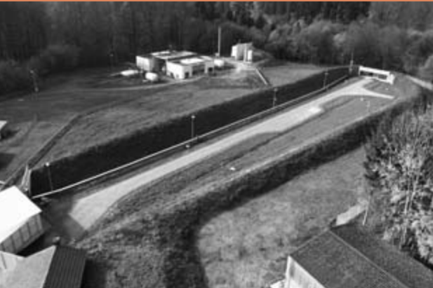
Die Laser-Freistrahlstrecke am DLR-Standort Lampoldshausen: Sie ist 130 Meter lang. DLR-Wissenschaftler analysieren und optimieren hier Eigenschaften und Fernwirkung von Laserstrahlen unter realen atmosphärischen Bedingungen.
