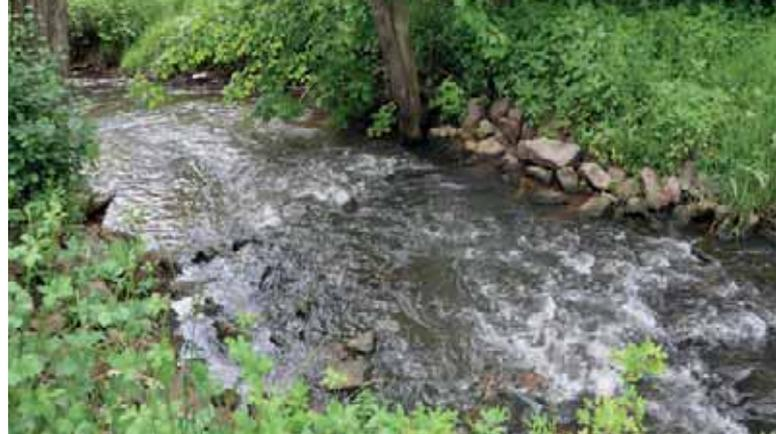
Die fertige Faschine kann nach der Wurzelbildung bei Niedrig- und Mittelwasser ihre Wirkung entfalten und die Strömung umlenken sowie die Böschung sichern.
