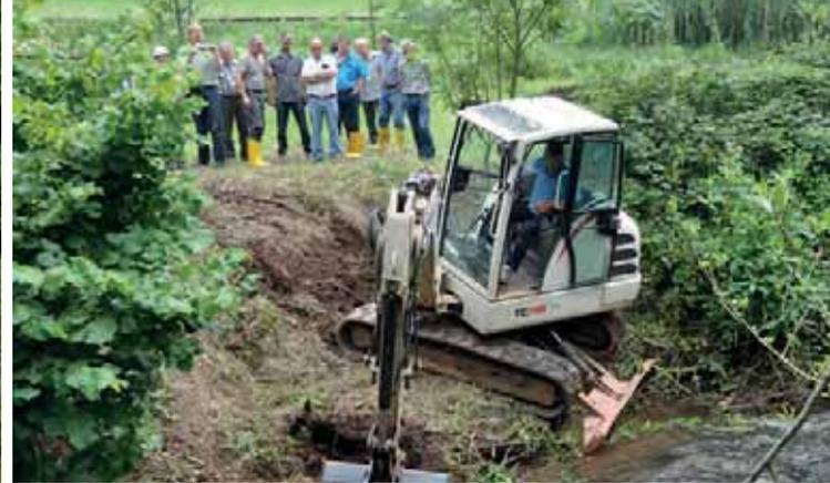
Die Faschine soll die Fließrichtung der Strömung an der Sohle umlenken. Dazu wurde die Einbaustelle ausgekoffert.
