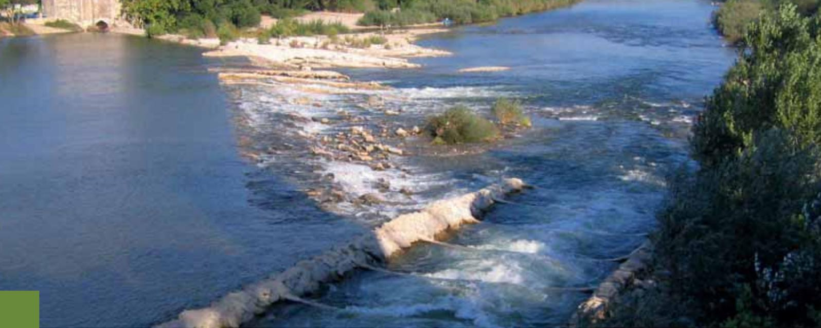
Im spitzen Winkel zwischen Ufer und Wehr positionierter Beckenpass in St. Martin an der Ardèche (Frankreich) (Foto: M. Redeker)
