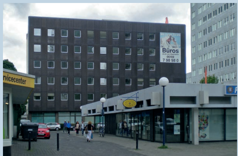
Foto 10 Ehemaliges Gebäude der IHK am Platz der Deutschen Einheit
