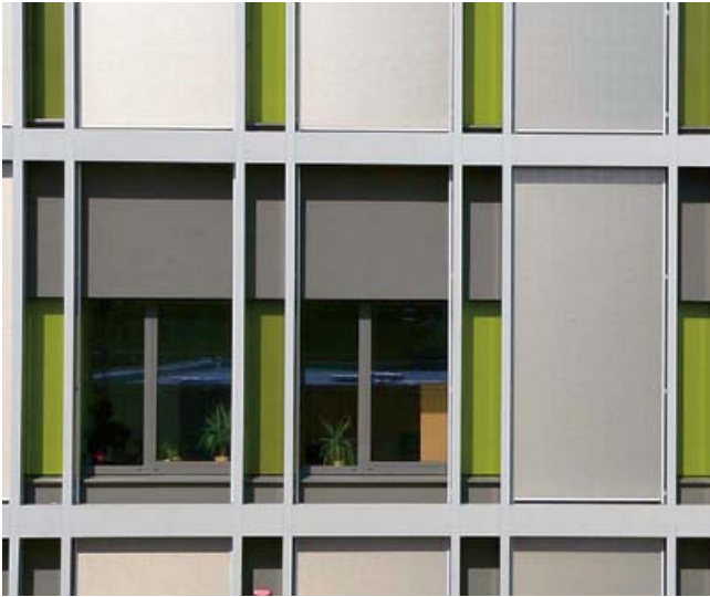
Abb. 134–135: Südfassade mit Sonnenschutz
