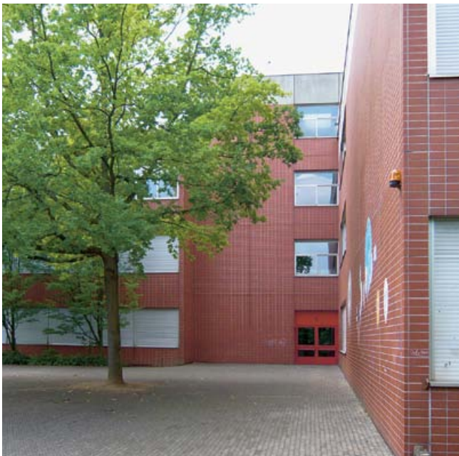
Abb. 102: Ostansicht des Bestandes
