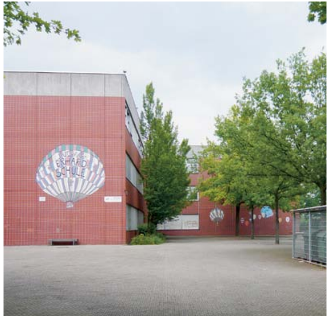
Abb. 101: Südansicht des Bestandes
