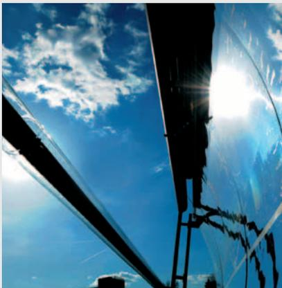
Bislang übertragen Thermoöle in Parabolrinnenkraftwerken die Wärme. Sie fließen in den Absorberrohren (dunkles Rohr links im Bild), nehmen die Wärme der Sonne auf und führen sie dem konventionellen Kraftwerksprozess zur Dampferzeugung zu. In der neuen Testanlage wird geschmolzenes Salz durch die Absorberrohre fließen.
