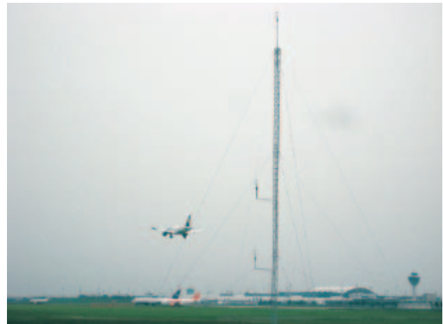
Der 20-Meter-Hauptmast des Ultraschall-Anemometer-Netzwerks in der Nordwest-Ecke des Flughafens München
