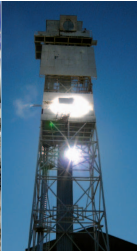
Der SSPS-Turm (Small Solar Power System) auf der Plataforma Solar de Almería, Spanien. Der Reaktor wird durch konzentrierte Solarstrahlung auf 800 bis 1.200 Grad Celsius aufgeheizt. Bei diesen Temperaturen wird dann Wasserstoff aus Wasser gewonnen.
