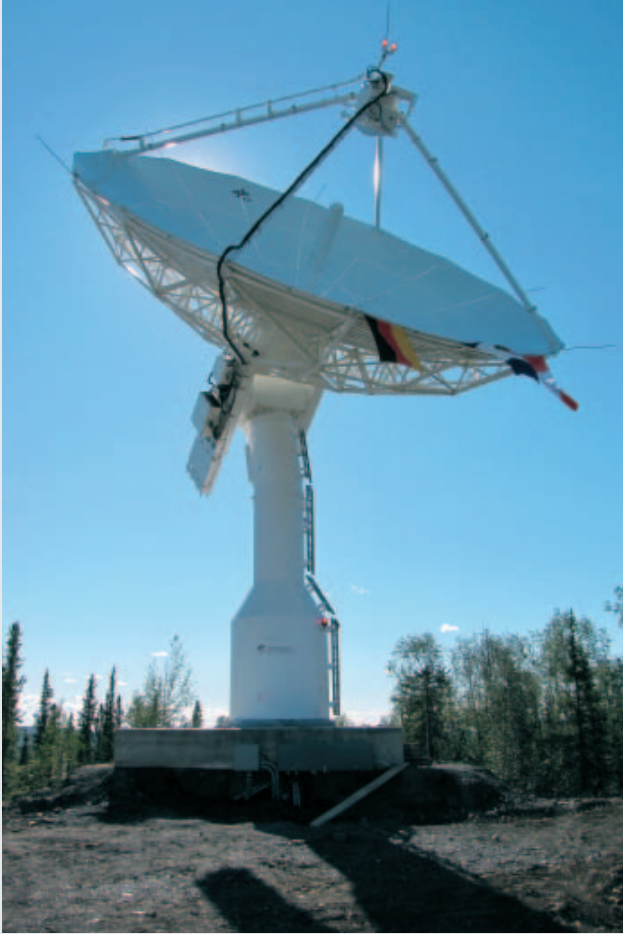
Die Antenne empfängt die Daten der beiden DLR-Radarsatelliten, sie hat einen Durchmesser von 13 Metern. Die Lage der Station im Norden Kanadas garantiert bestmöglichen Empfang.
