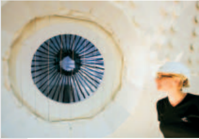
Kontrollblick auf die dunklen Absorberrohre im Strahlungsempfänger
