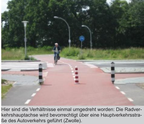
Hier sind die Verhältnisse einmal umgedreht worden: Die Radverkehrshauptachse wird bevorzugt über eine Hauptverkehrsstraße des Autoverkehrs geführt (Zwolle).
