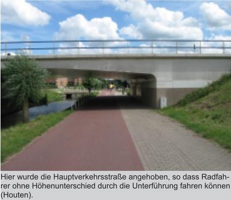
Hier wurde die Hauptverkehrsstraße angehoben, so dass Radfahrer ohne Höhenunterschied durch die Unterführung fahren können (Houten).
