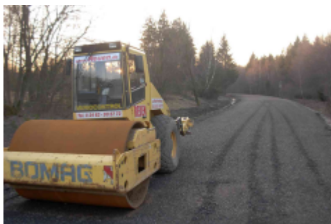
Seit dem feierlichen Spatenstich in Roetgen wird nun schon kräftig gebaut.
