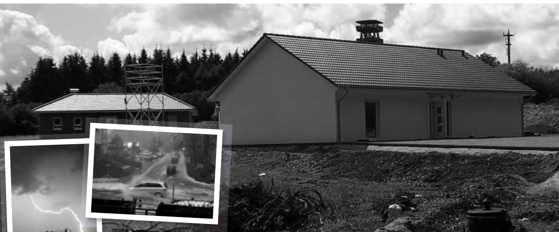
Die Baumaßnahmen an den Räumlichkeiten der Ausstellung „Wetter, Klima, Mensch“ gehen gut voran.
