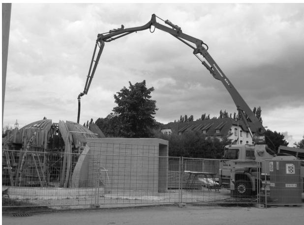
Arbeit, denn es waren mehr als 3 000 Einzelbretter von 10 cm Breite auf eine Länge zwischen 10 und 40 cm zu schneiden und auf die Unterkonstruktion zu nageln, damit später der kugelförmige Charakter und die horizontale Schalung im Innern der Kapelle sauber zur Geltung kommen (Abb. 2). Diese Arbeiten nahmen 11 Wochen in Anspruch und dauerten bis in die zweite Oktober- Hälfte.
