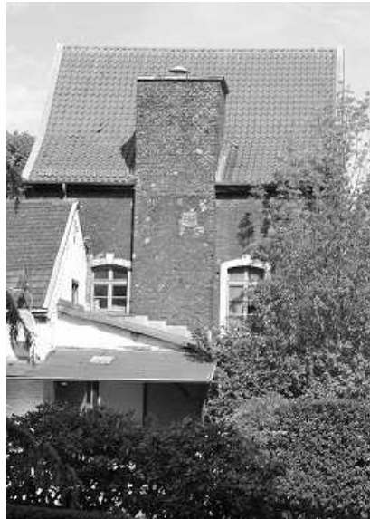
Rückseite des Pumpenhauses mit dem mächtigen Kamin
