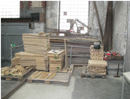
Zugeschnittene Segmente für das Lehrgerüst der Kapellenkuppel
