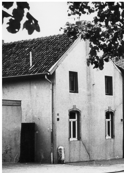
Haus Becker vor dem Abriss. An der vorderen Hausecke ist der Lochstein zu erkennen
