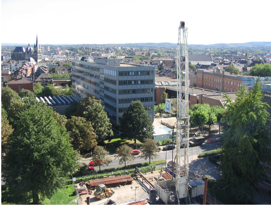
Abbildung 3: Bauplatz des Super C. Im Hintergrund erkennt man am Aachener Dom die unmittelbare Nähe zur Innenstadt
