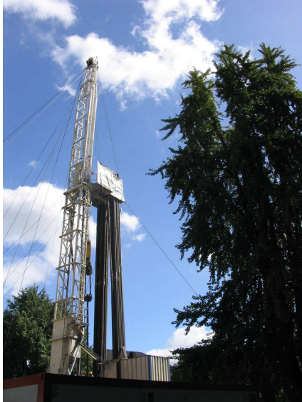
Abbildung 4: Bohrgerüst während der Arbeiten
