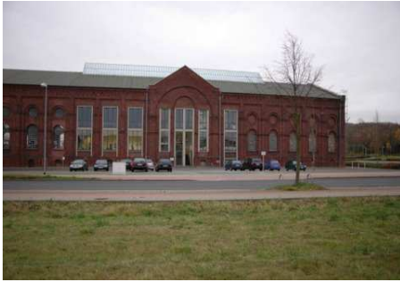
Die Kraftzentrale in Alsdorf. Rechts vom Haupteingang befinden sich die neuen Büroräume des Vereins
