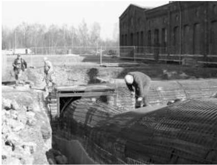
Armierungsarbeiten oberhalb der Baue des Bremsberges
