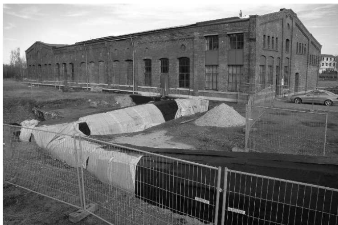
Blick auf die Strecke. Noch ist die Betonkappe nicht mit Erde überdeckt und für den Besucher unsichtbar.
