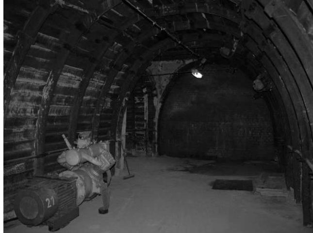
Das Brückenfeld des neuen Streckenabschnittes.
