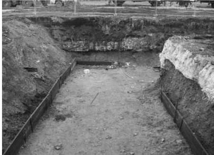
Baugrube des Streckenabschnittes vor Einbringen des Betonkastens von der Schmiede aus gesehen
