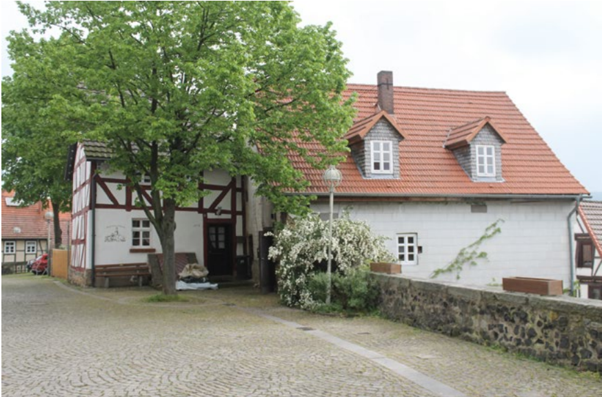
Aktuelle Sanierungsmaßnahme durch Genossenschaft in Felsberg, Quelle: Ralf Dötig
