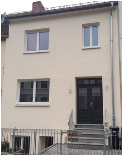
Bremen: Durch KIQ saniertes Objekt, Quelle: KIQ-Bremen
