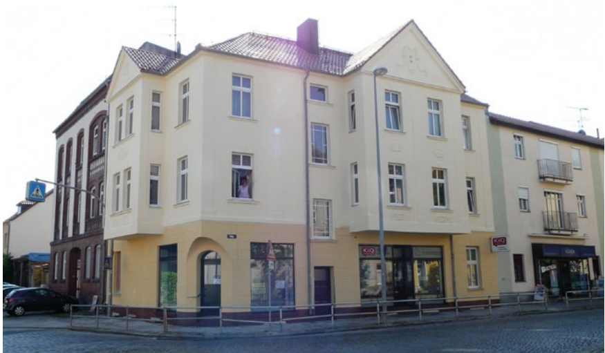
KIQ-Altstadtbüro in Luckenwalde im sanierten Objekt Haag 1A, Quelle: BIG-Städtebau GmbH
