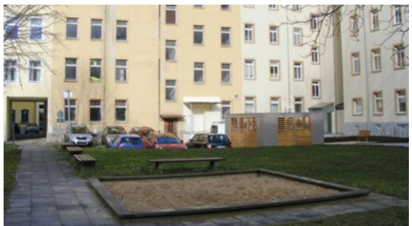
Neu gestalteter Innenhof im Karree 1, Quelle: Haus & Grund Chemnitz und Umgebung e.V.
