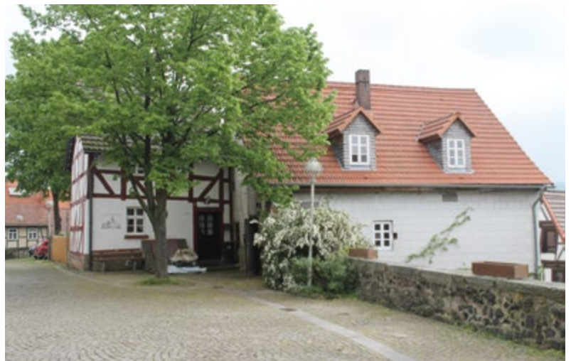
Aktuelle Sanierungsmaßnahme durch Genossenschaft, Quelle: Ralf Dötig
