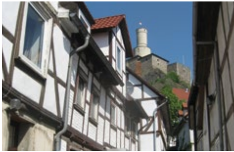
Fachwerkhausquartier mit Aufwertungspotential in Felsberg, Quelle: empirica
