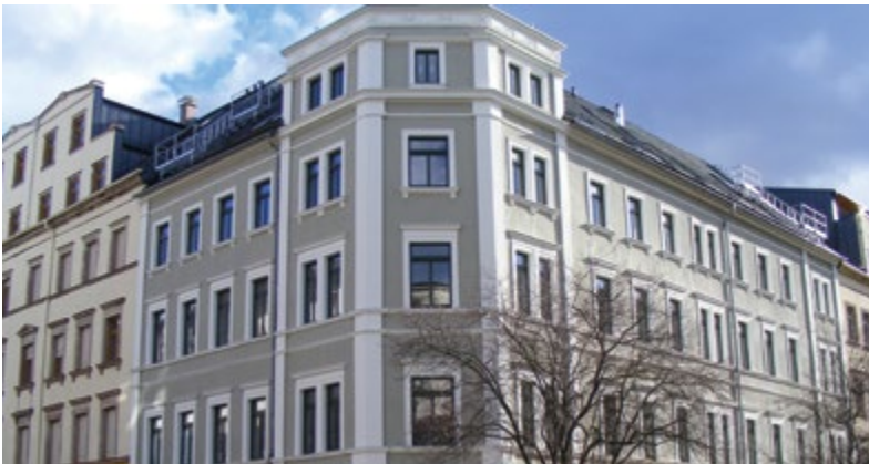
Saniertes Objekt am Brühl, Quelle: Haus & Grund Chemnitz und Umgebung e.V.
