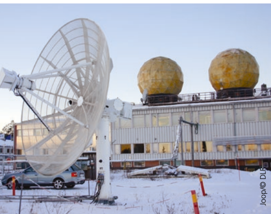
ESRANGE Hauptgebäude ESRANGE main building
