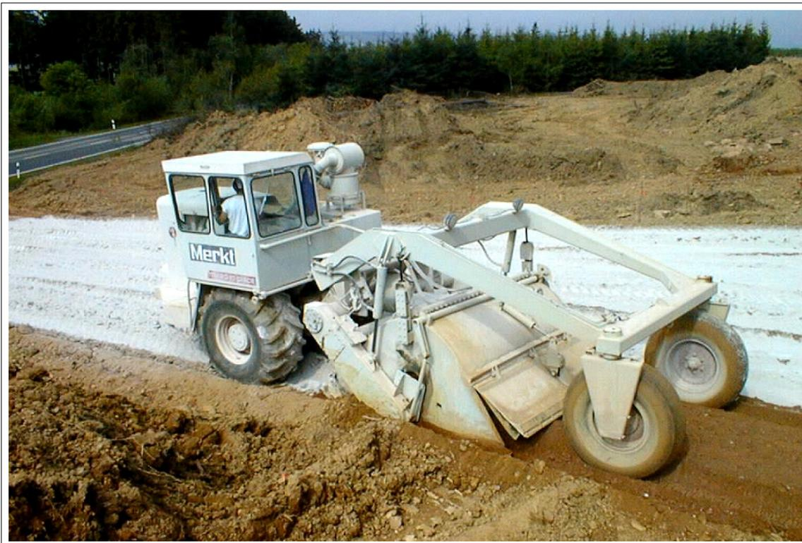
Bild 11.7: Einfräsen des Kalkes
