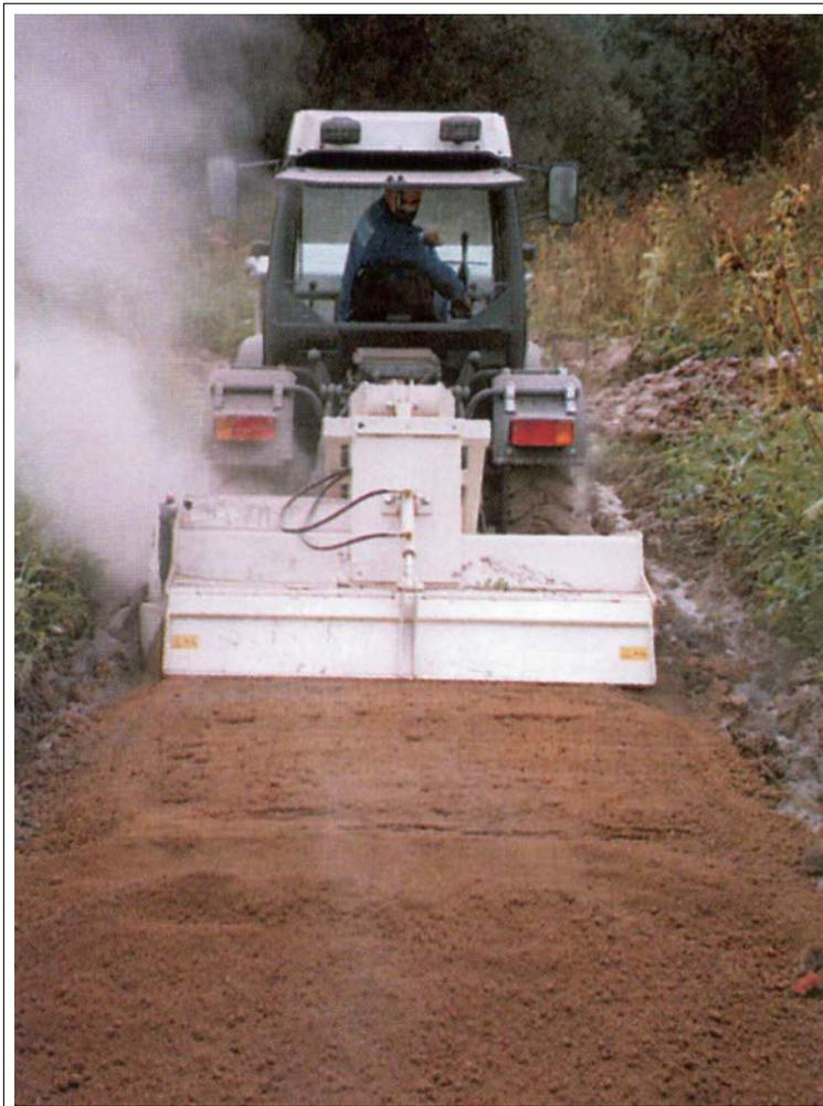
**Bild 11.9: Einfräsen des Kalkes - auch auf kleinen Flächen**
