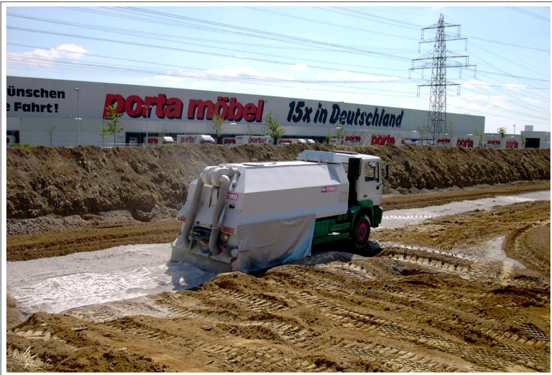
Bild 11.4: Verteilen des Kalkes
