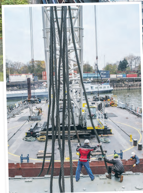
Der Schwergutumschlag ist Präzisionsarbeit.
