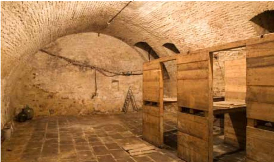
Massivwände speichern die Energie aus der Sonneneinstrahlung, so dass sie auch im Winter gute Trocknungspotenziale haben und ihre raumseitige Oberfläche normalerweise nicht so stark abkühlt, dass sich Kondensfeuchte auf der Wandoberfläche bildet. Diese Eigenschaft stellt die Dämmung, insbesondere die äußere Dämmung, dicker Massivwände in Frage. Da äußere Dämmungen keine Wärme speichern, kühlen sie in der Nacht oft stark aus. Dadurch kann sich verstärkt Tauwasser aus dem
