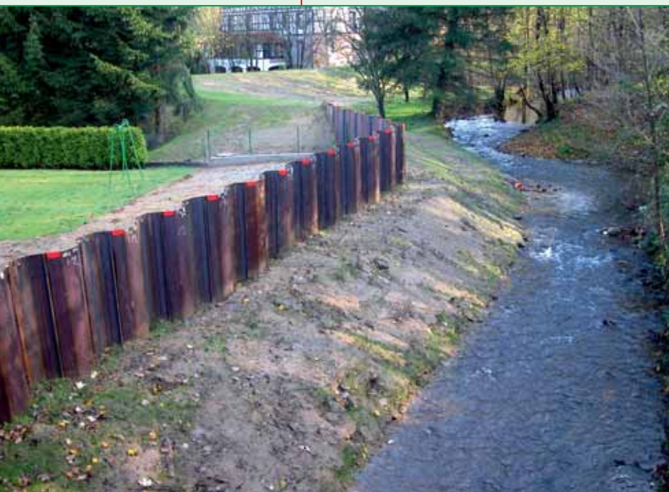
Hochwasserschutz am Krabach, Eitorf
