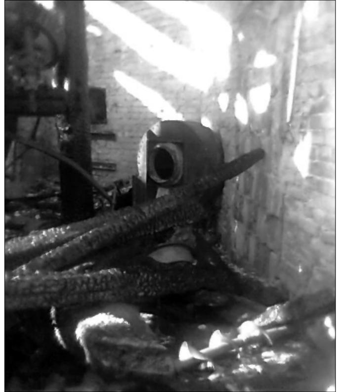
**Dieses Foto dokumentiert die Reste des Spurbalkens des Mahlganges, das Kegelrad des Mahlgang-Vorgeleges mit Holzzähnen und einen Teil des Mühleisens.**
