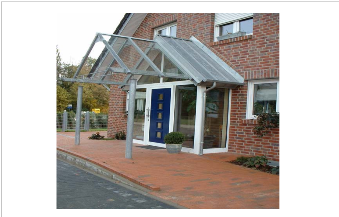
Abbildung 111: Ein Zugang ohne Treppe zur Wohnung erschreckt keinen Rollstuhlfahrer
