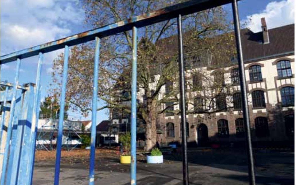
Vorbereitungen für die aufwendige Sanierung des Gitterzauns
