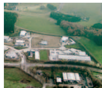
Luftaufnahme Gewerbegebiet Klingsiepen
