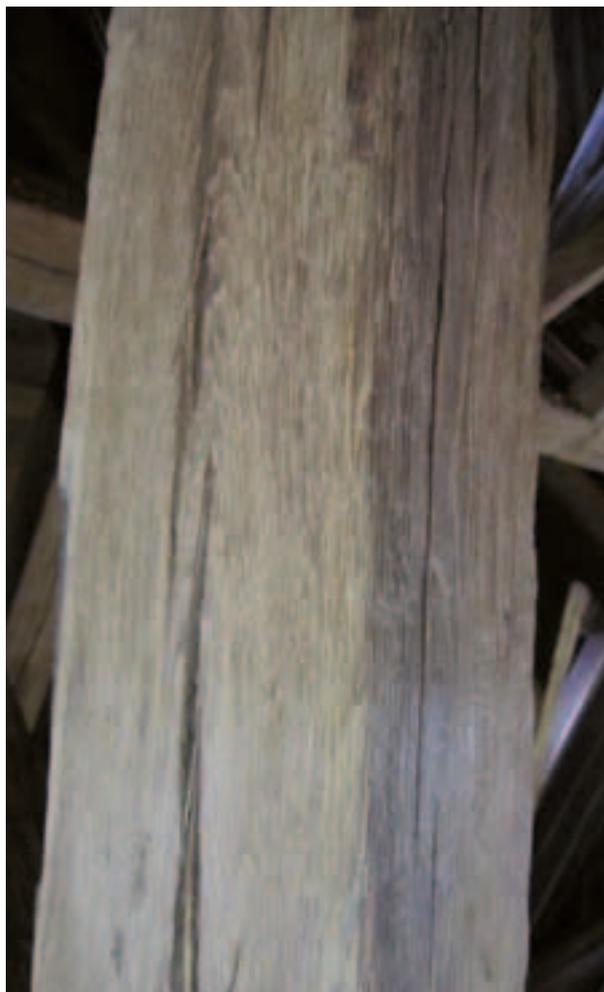
Meisenheim, Schlosskirche, Oberfläche der Eichenkonstruktion nach der Reinigung mit rotierender Kunststoffbürste
