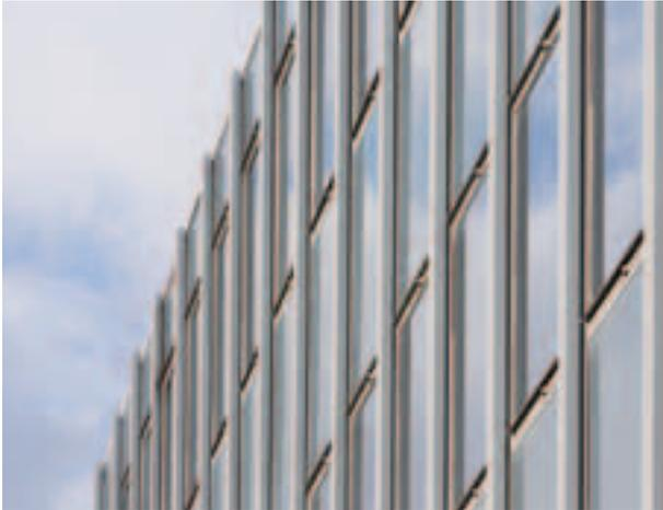
Abbildung 2: Fassade mit opaken Brüstungspaneelen
