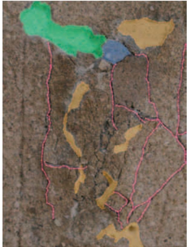
**Abbildung 2a und 2b:** Foto (a) und 3-D-Risskartierung mit dem Trackingsystem (b) einer Hohlstelle der Putzritzungen am Magdeburger Dom
