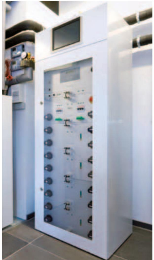
Neuer Batteriespeicher, Kapazität 13,2 kWh
