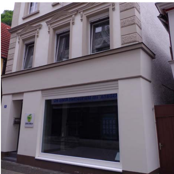
Im Erdgeschoss des Gebäudes (ehemals Bürobedarf) befindet sich heute die Schülerfirma ObStBüro
